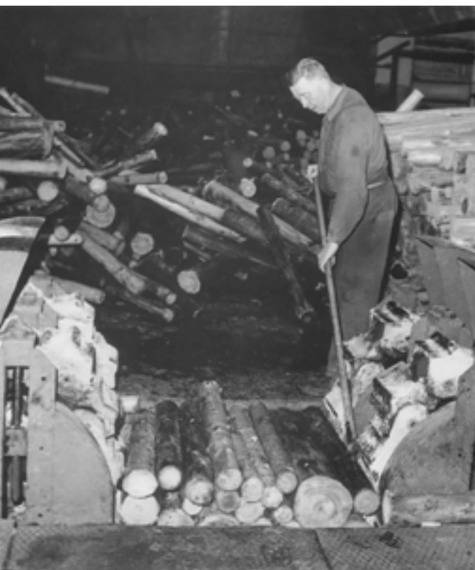
Manuell inmatning av ved i ett kedjeslipverk, före 1944.
