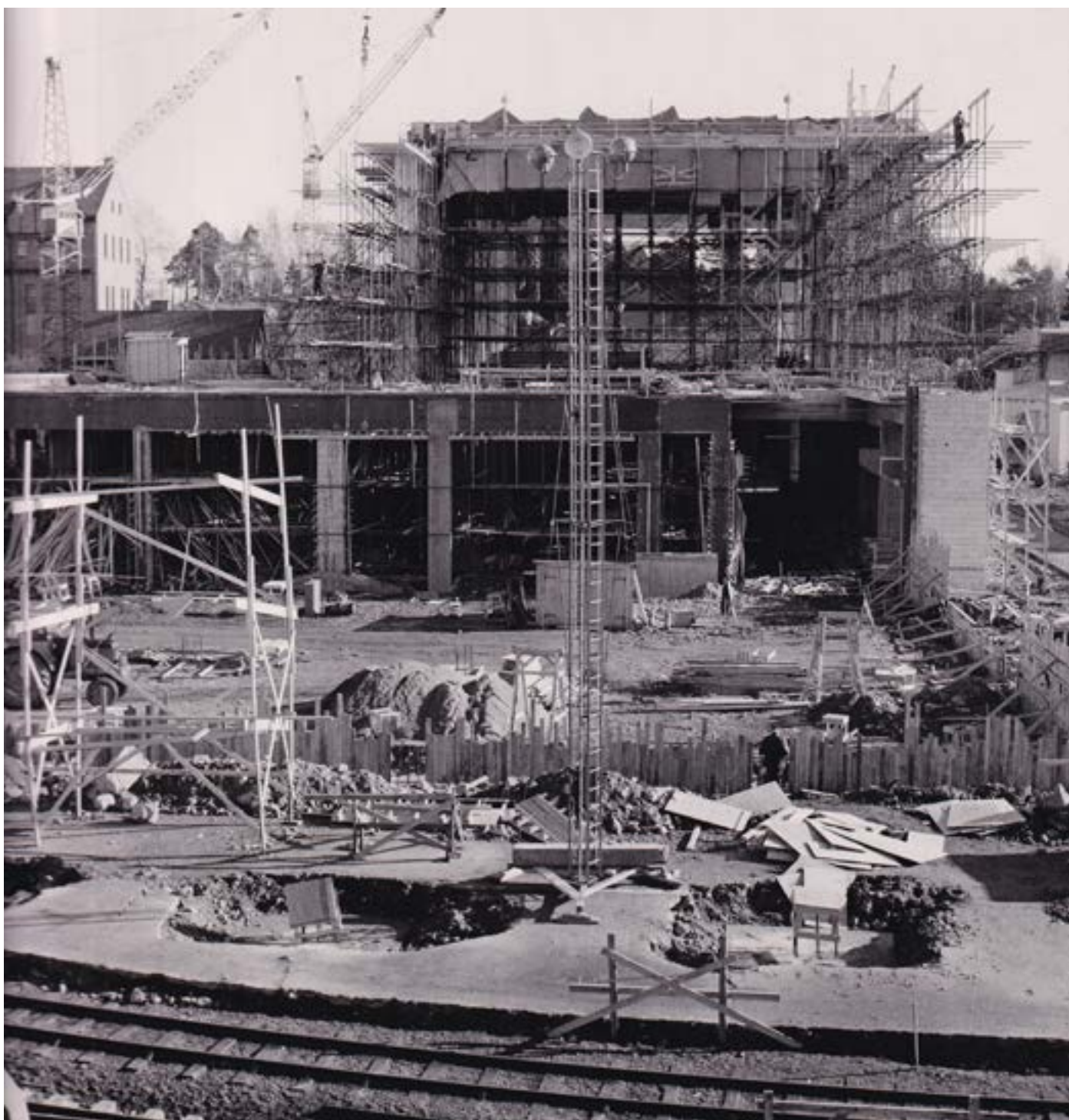
Byggnation av PM 3:s maskinhall sett från hamnen.
